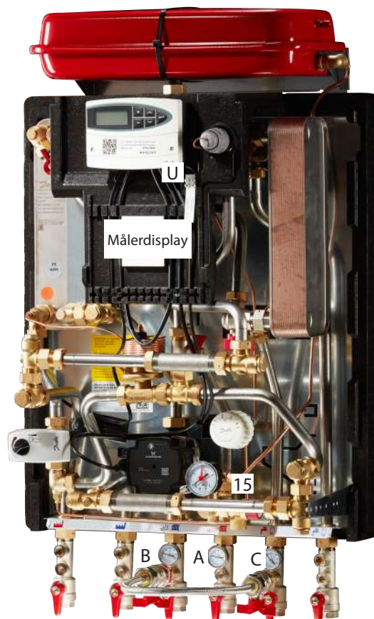
Akva Lux II VXE med ECL Comfort 110
