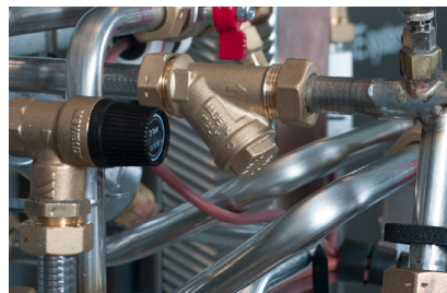
16. Snavssamler/snavsfilter til opsamling af snavs i rørledningerne (standard).
