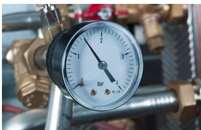
26. Manometer for aflæsning af trykket i radiatorkredsen.
