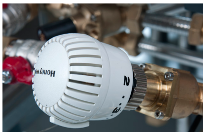
18. Termostat til regulering af varmtvandstemperaturen.
