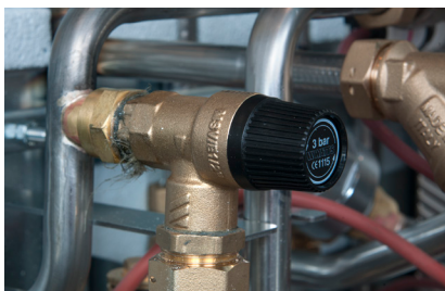
31A. Sikkerhedsventil for radiatorkreds med åbningstryk på 3 bar.
