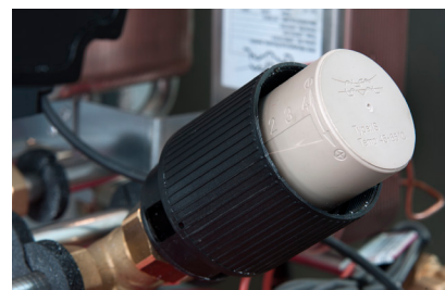
18. Termostat til regulering af varmtvands-temperaturen.
