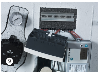
9. Vejrkompensatoren er fastgjort på en DIN skinne som demonteres, og vejrkompensatoren og en eventuel energimåler kan nu føres gennem hullet i isoleringskappen. Isoleringskappen er nu frigjort for alle el-forbindelser og kan fjernes helt.
