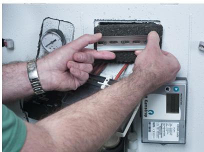
9. Vejrkompensatoren er fastgjort på en DIN skinne som demonteres, og vejrkompensatoren og en eventuel energimåler kan nu føres gennem hullet i isoleringskappen. Isoleringskappen er nu frigjort for alle el-forbindelser og kan fjernes helt.
