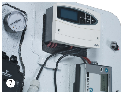
7. Ønskes isoleringskappen helt demonteret, kan vejrkompensatoren og en eventuel energimåler demonteres.
