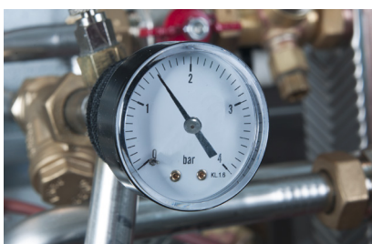
26. Manometer for aflæsning af trykket i radiatorkredsen.
