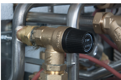
31A. Sikkerhedsventil for radiatorkreds med åbningstryk på 3 bar.
