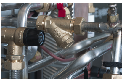
16. Snavssamler/snavsfilter til opsamling af snavs i rørledningerne (standard).
